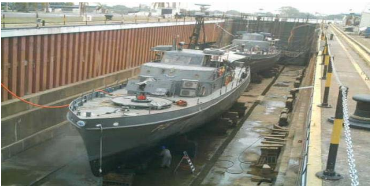
Figura 9: Vista atual do Dique Getúlio Vargas.
