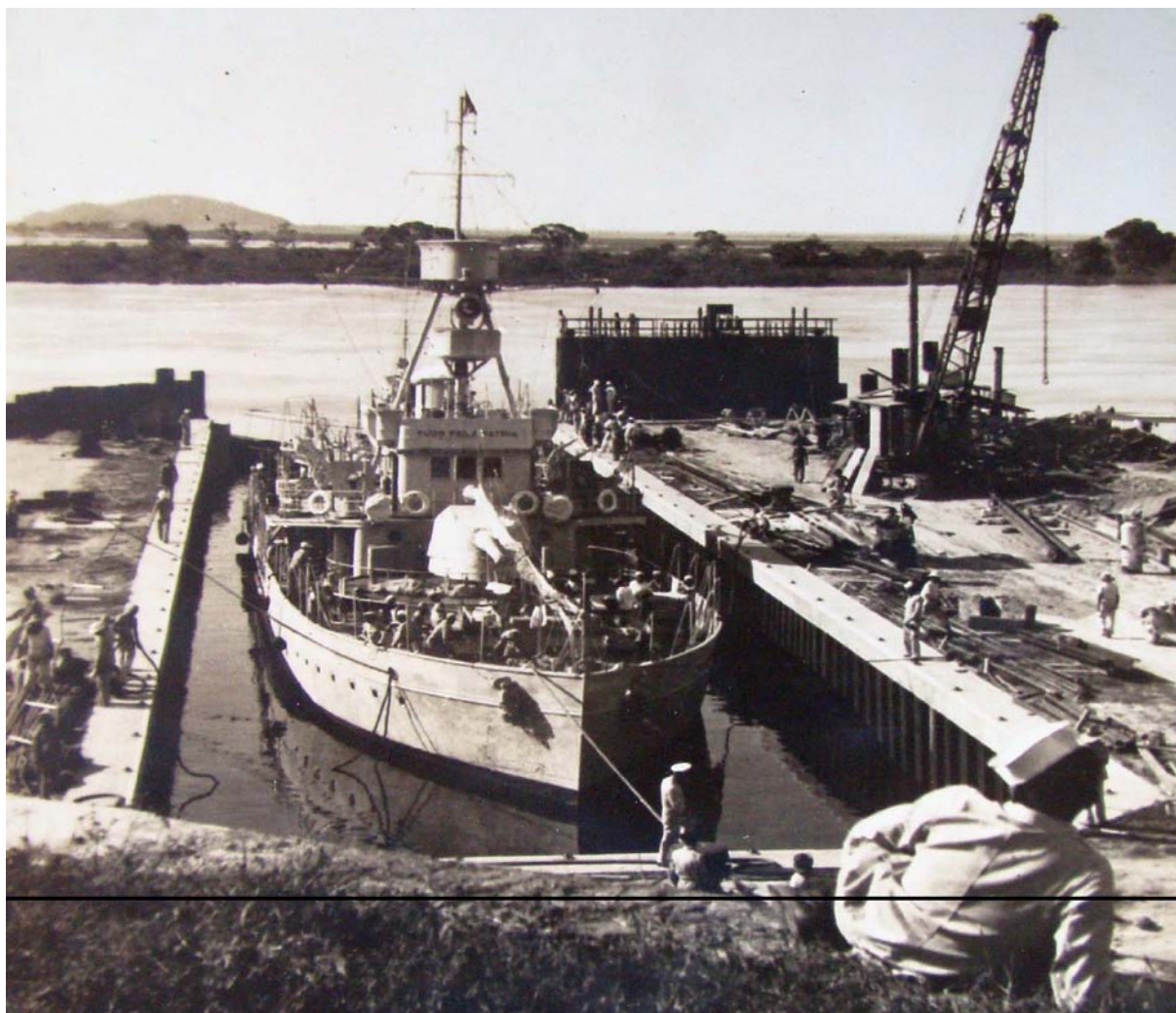
Figura 8: Dique Getulio Vargas, anteriormente denominado Dique de Ladário, tendo em destaque o Monitor Parnaíba. Fonte: https://www.naval.com.br/blog/2017/11/16/80-anos-do-monitor-parnaiba-terceira-parte/ 12 de novembro de 2017 <acessado em: 13/01/2018>
