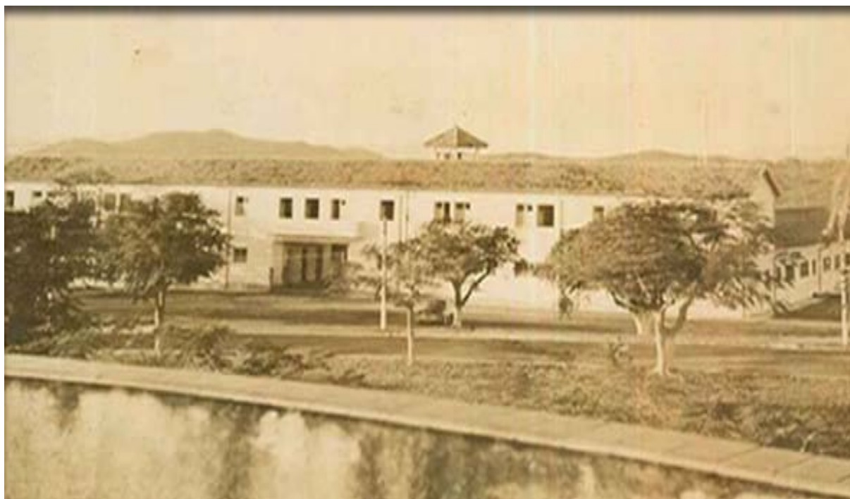
Figura 4: Antiga edificação da Aviação Naval (1932). Ao centro a torre de controle. Fonte: Comunicação Social do 6º Distrito Naval
