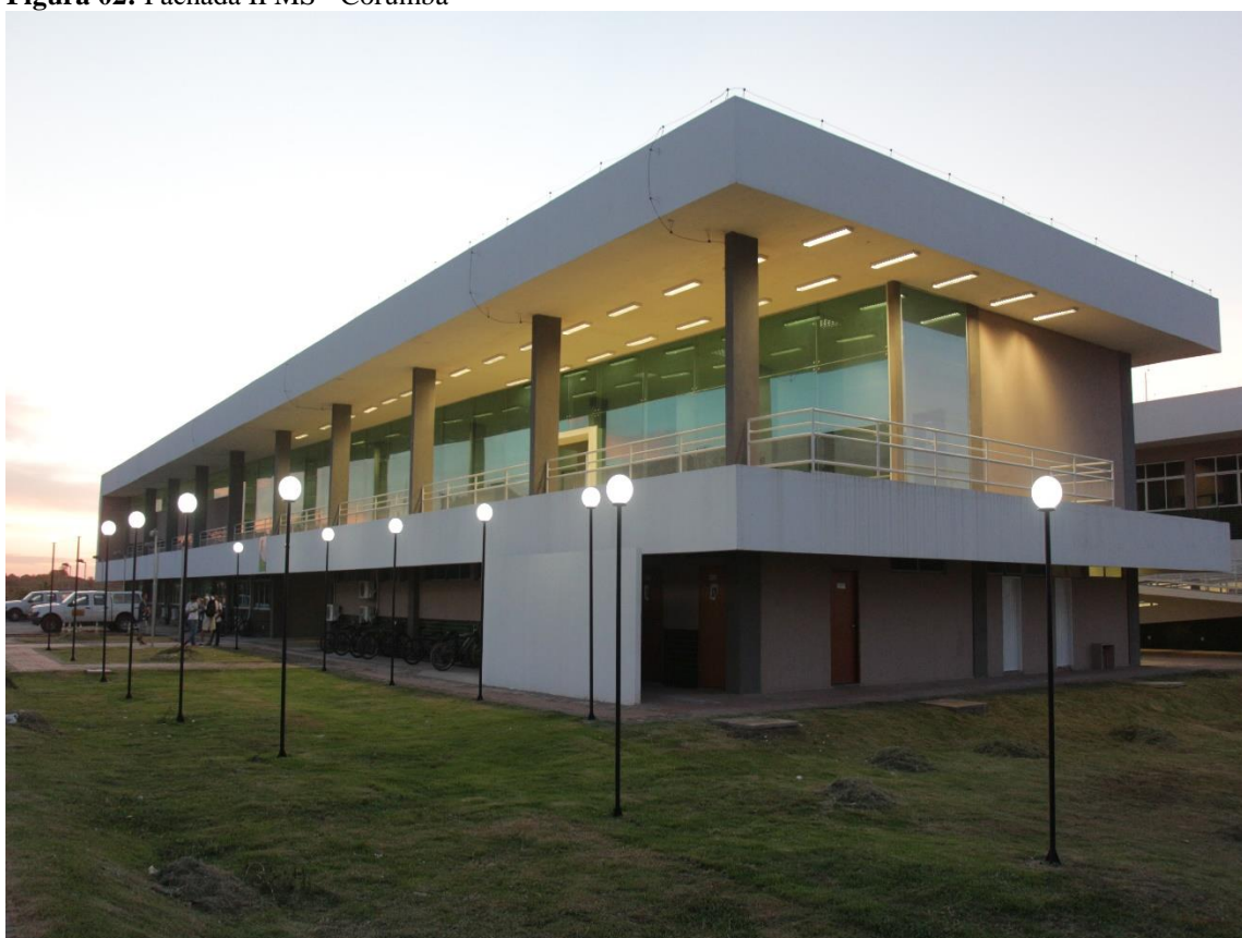
Figura 02: Fachada IFMS - Corumbá
